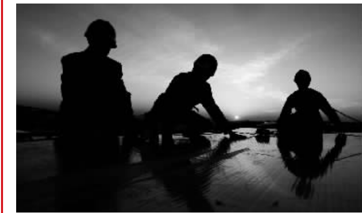
2010年10月,工人在安装贵阳奥体中心看台顶棚。本报记者 王京 摄
