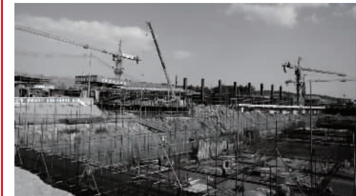
2009年6月,正在建设中的贵阳奥体中心。本报记者 王京 摄
