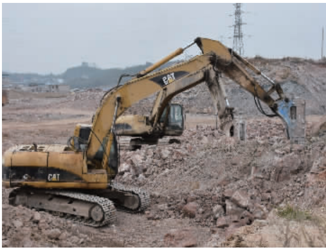
市政道路施工现场。
