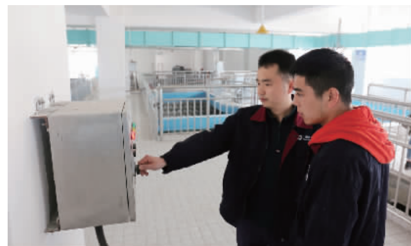
七彩湖污水处理厂技术人员正在检查设备。
