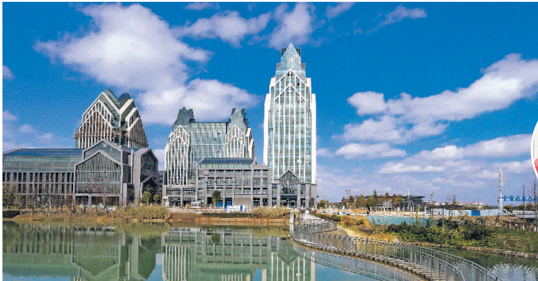
建设中的贵阳大数据科创城。
