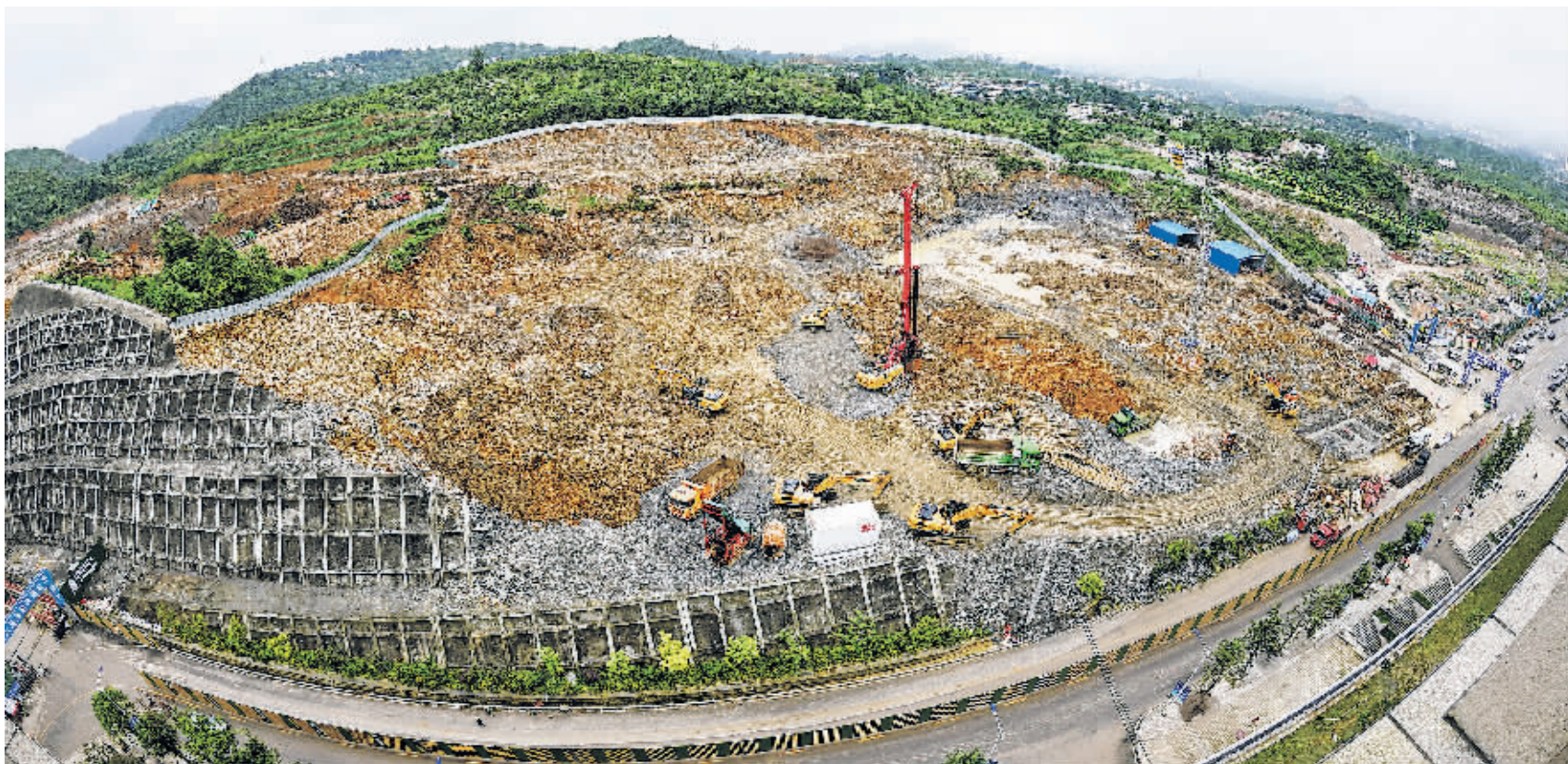
南明智能制造产业园三期项目施工现场。
