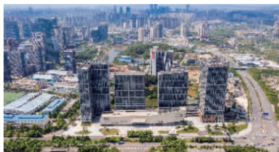
图为:阳光城·启航中心项目
