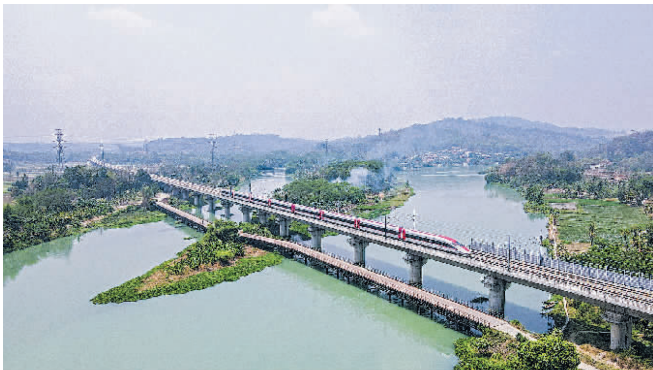
2023年9月30日在印度尼西亚普哇加达拍摄的一列行驶中的雅万高铁高速动车组(无人机照片)。新华社/传真
