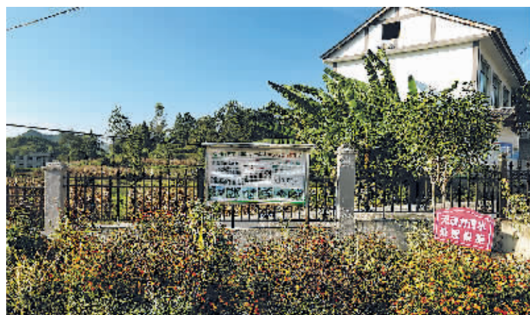
前丰村无动力分散式污水处理设施。
