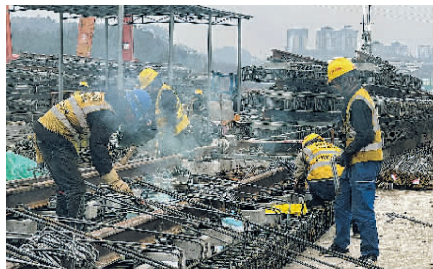
2月18日,施工人员在贵阳轨道交通S1线一期工程轨道01标段项目天石区区间路基段铺轨基地工作。
