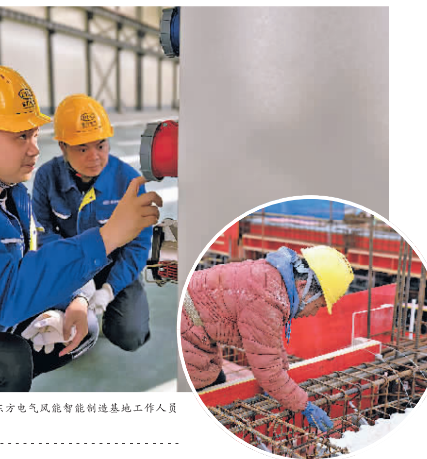
▲贵州希望实验学校项目现场,工人正在绑扎钢筋。
