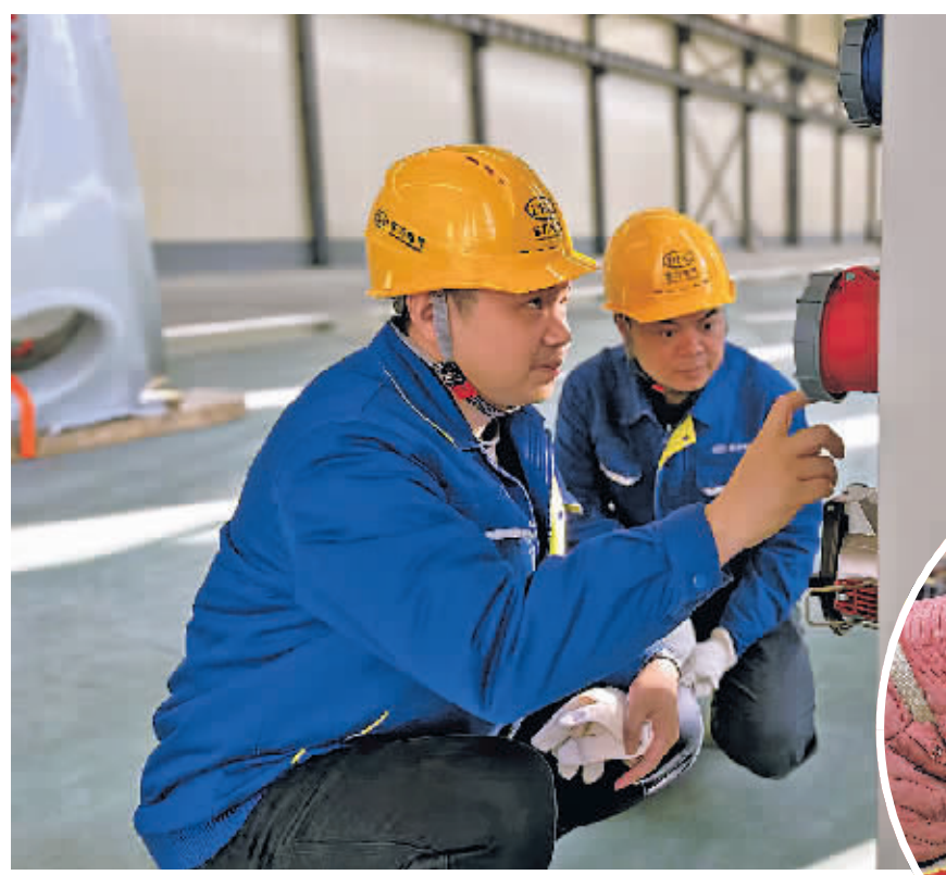
▲贵州装配建筑绿色产业园项目内,东方电气风能智能制造基地工作人员正在安装调试生产设备。
