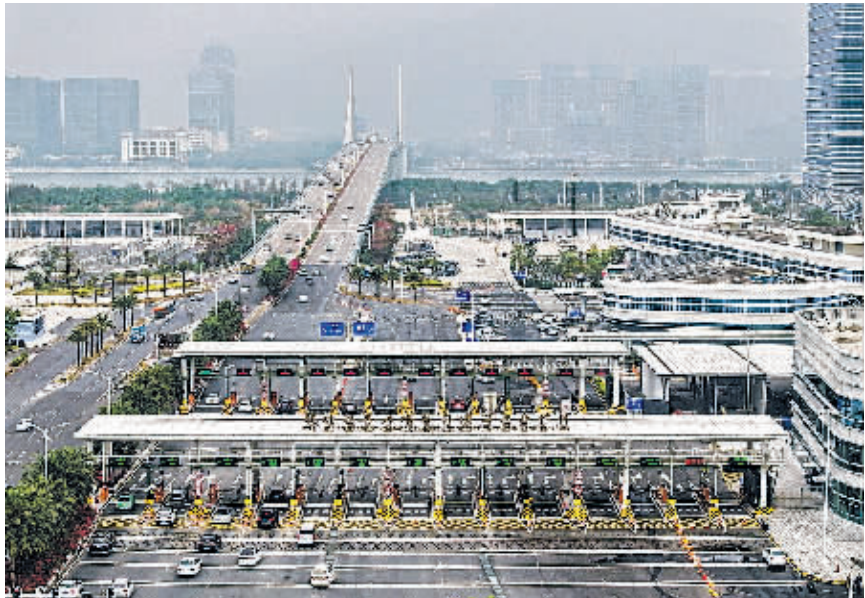
横琴大桥“二线”通道海关监管区(无人机照片,2月29日摄)。
