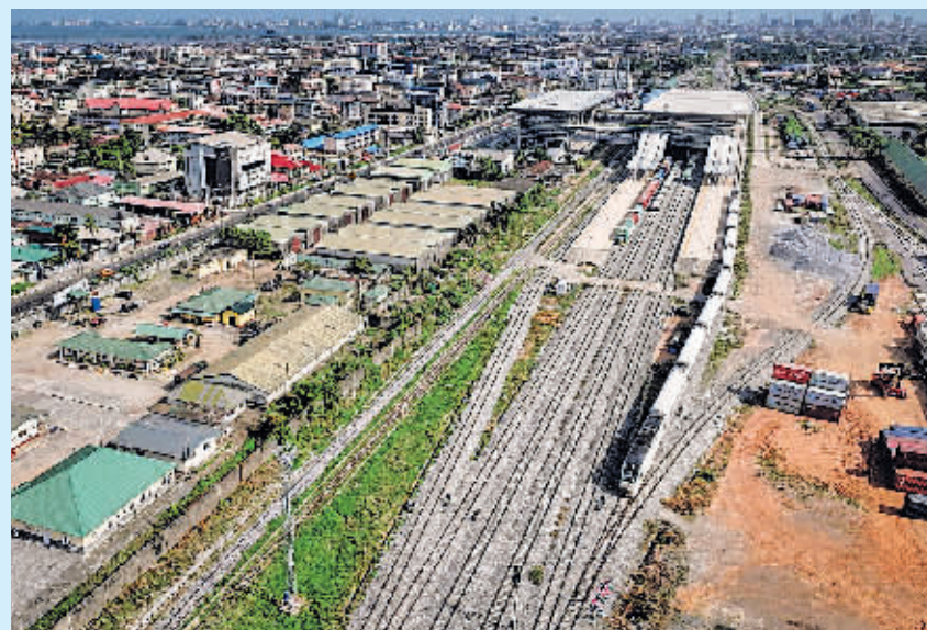
2021年6月,在共建“一带一路”倡议指引下,由中国土木工程集团有限公司(中土集团)承建的连接拉各斯和伊巴丹的铁路(拉伊铁路)正式通车运营,干线全长约157公里,支线长约7公里,采用现代化铁路标准,设计时速150公里。图为2024年3月2日,在尼日利亚拉各斯,列车从拉伊铁路莫博拉吉·约翰逊火车站驶出(无人机照片)。
