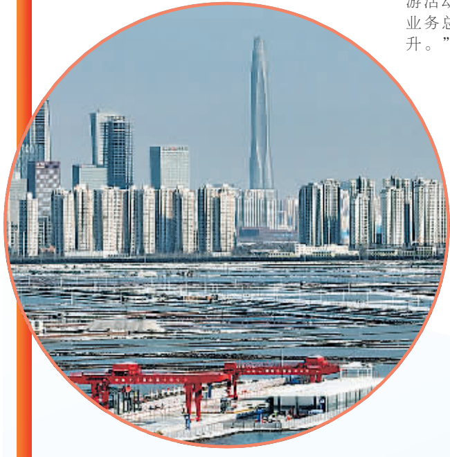
2024年1月18日,由中铁十四局承建的津潍高铁天津海河隧道超大直径盾构机“津城一号”顺利始发,标志着京津冀地区开挖直径最大、掘进距离最长的高铁盾构隧道正式开始掘进。
