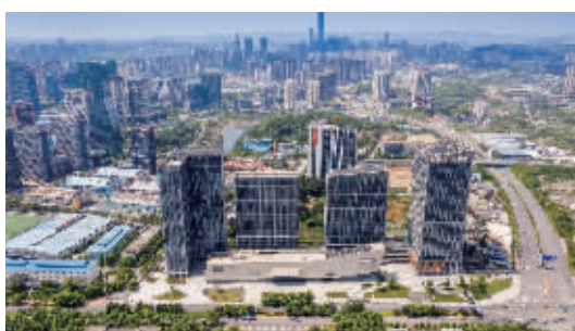
图为:阳光城·启航中心项目
