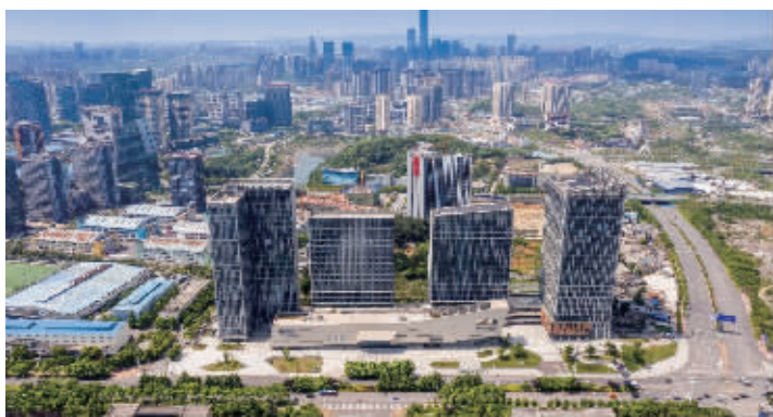
图为阳光城·启航中心项目。
