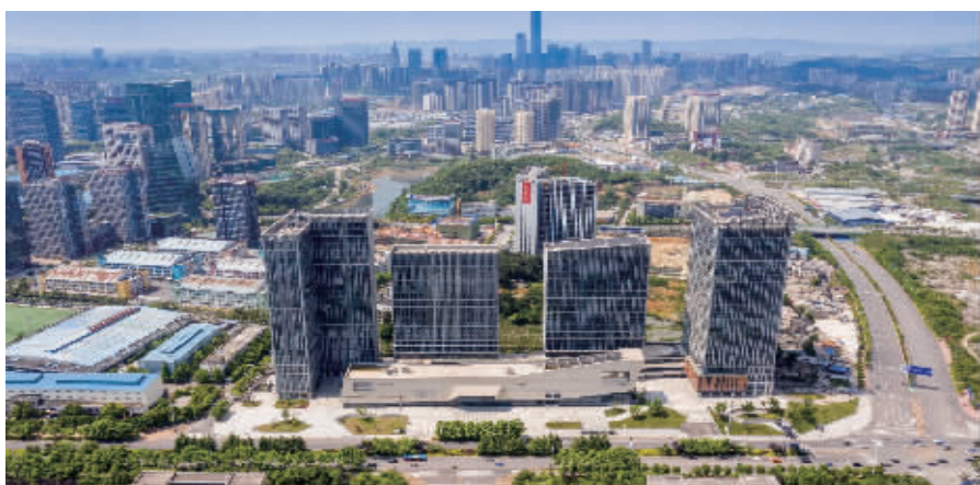
图为:阳光城·启航中心项目
