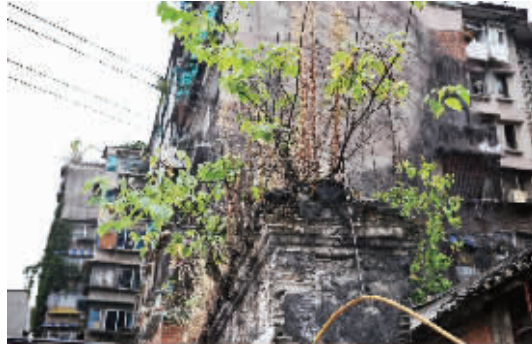
汉湘街上所剩无几的老建筑墙体。
