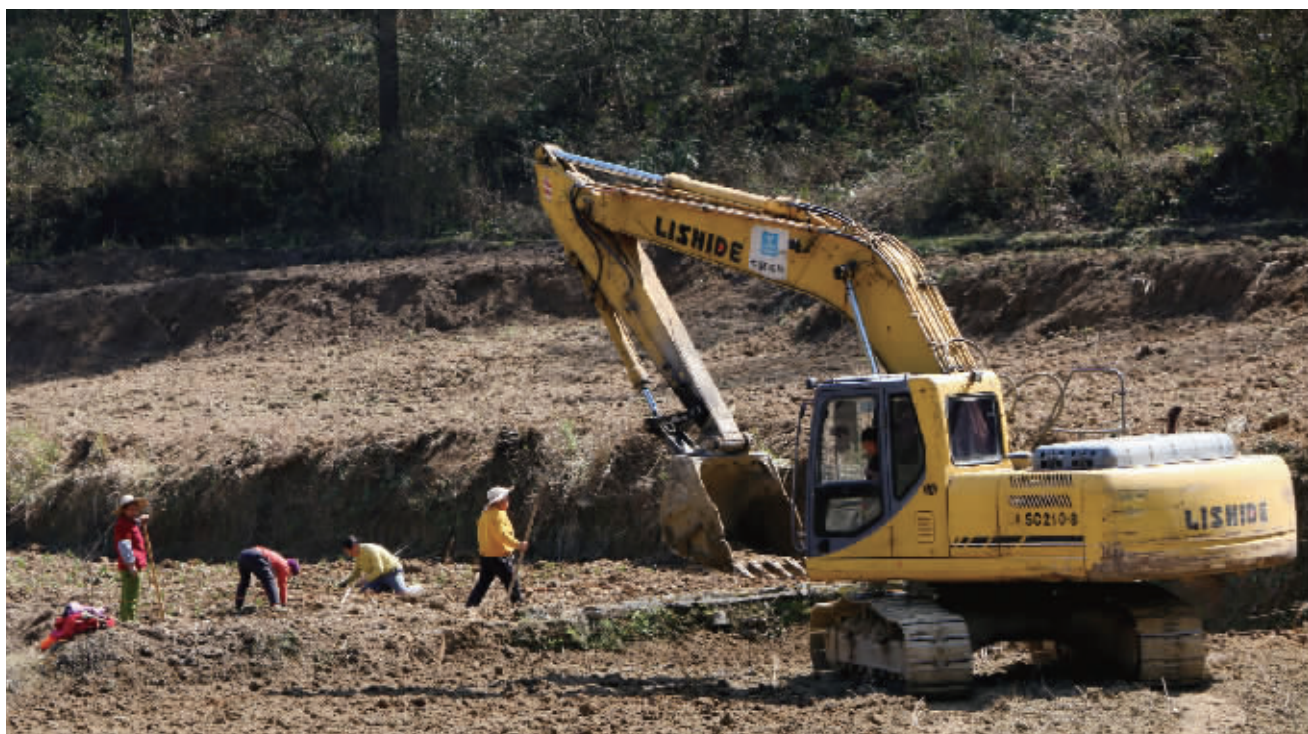
图为开阳县城关镇顶方村精品水果种植基地建设现场。
