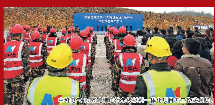
中科电气10万吨锂电池负极材料一体化项目开工仪式现场。
