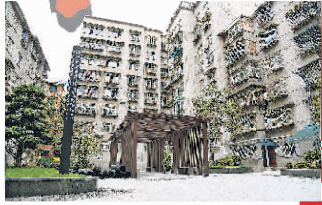
改造完成的电力巷居民院落。
