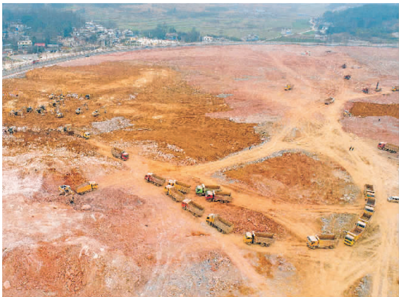
中科电气10万吨锂电池负极材料一体化项目现场,运输车辆穿梭不停。
