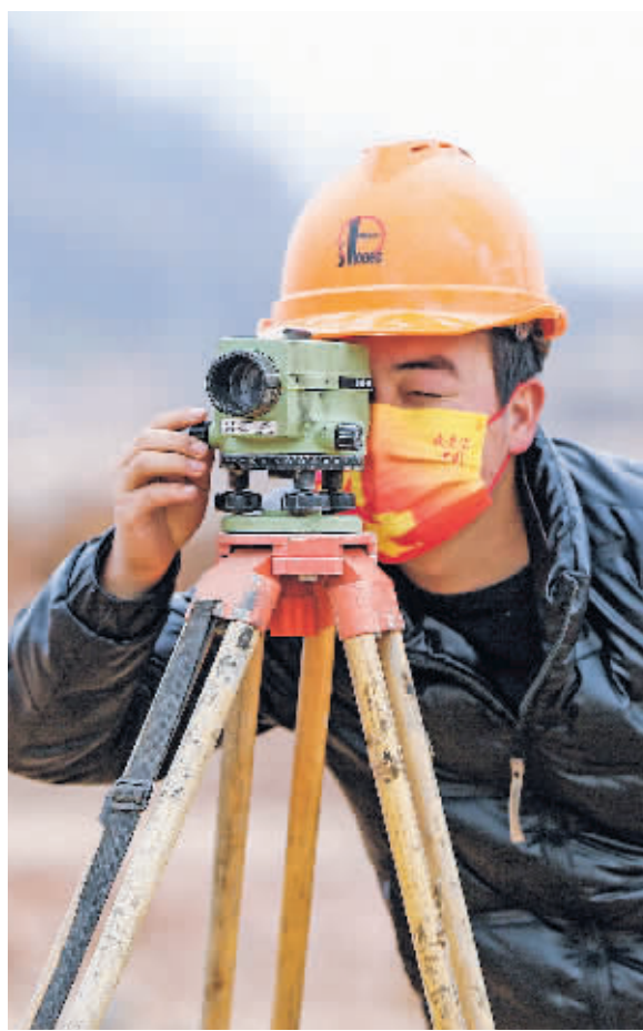
3月4日,技术人员在中科电气10万吨锂电池负极材料一体化项目现场进行测量工作。
