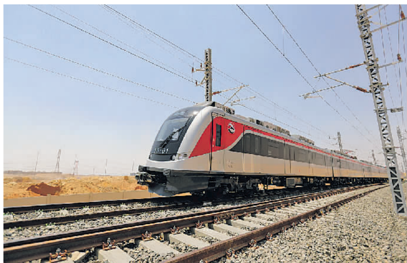
由中国企业承建的埃及斋月十日城轻轨铁路3日通车试运行,这是埃及第一条电气化铁路。埃及斋月十日城轻轨铁路位于埃及首都开罗东部,是连接开罗市区与新行政首都、斋月十日城和东部沿线卫星城的重要纽带,也是中埃“一带一路”合作旗舰项目之一。图为7月3日在埃及开罗东部拍摄的一列驶向埃及新行政首都方向的试运行轻轨列车。新华社/传真
