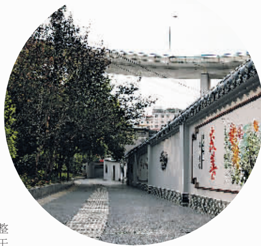
▲升级改造后的新添大道南段604号支巷。
