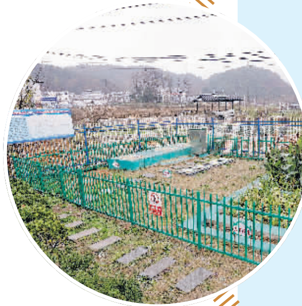
▲观山湖区金华镇翁井村卡子山金竹山片区污水处理工程2号站点。
